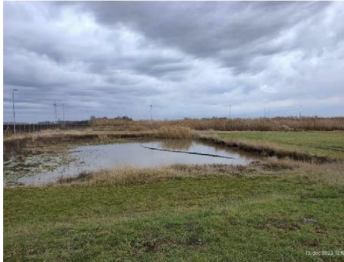
Слика 26. Прихватна лагуна за отпадне воде са ППОВ
